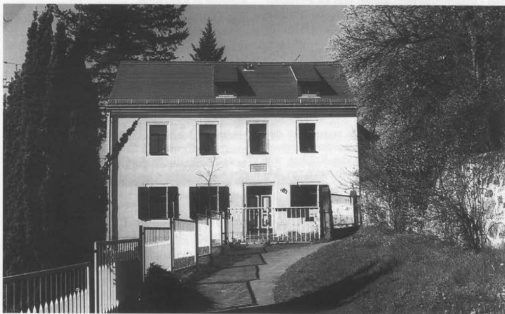
Das erste Klotzscher Schulhaus an der Hendrichstraße aus dem Jahre 1840. Nach der Sanierung im Jahre 1997, von Altklotzsche aus, fotografiert.
