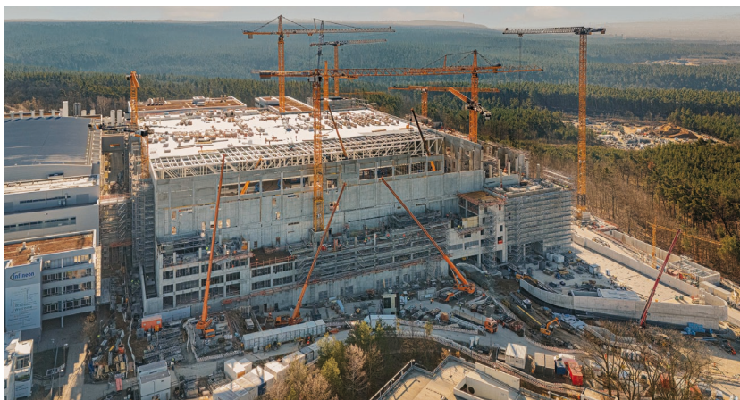
Baustelle Infineon März 2025 (Foto: Infineon)
